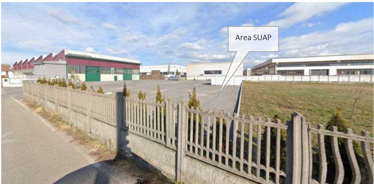
Figura 3 - vista dalla via Biciccerà dell'area SUAP
